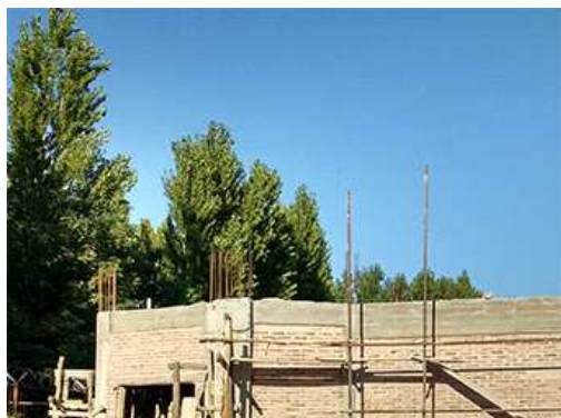
Iglesia de Plottier - Neuquén: El 21 de febrero se colocó el Hormigón del techo
